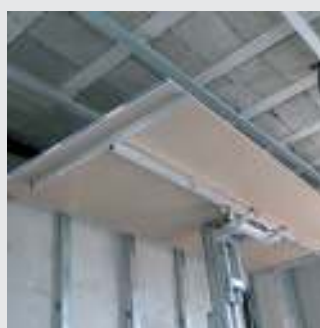
Montaje de paneles de pladur.
